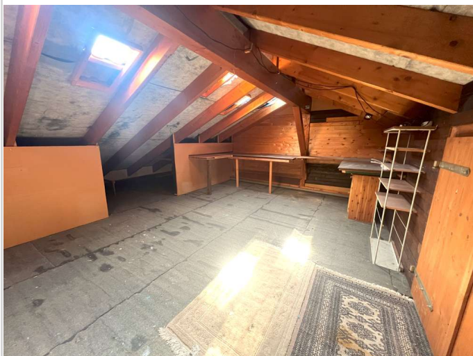
Dachraum über der Garage
